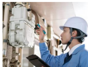
ビル・道路などの設備点検
